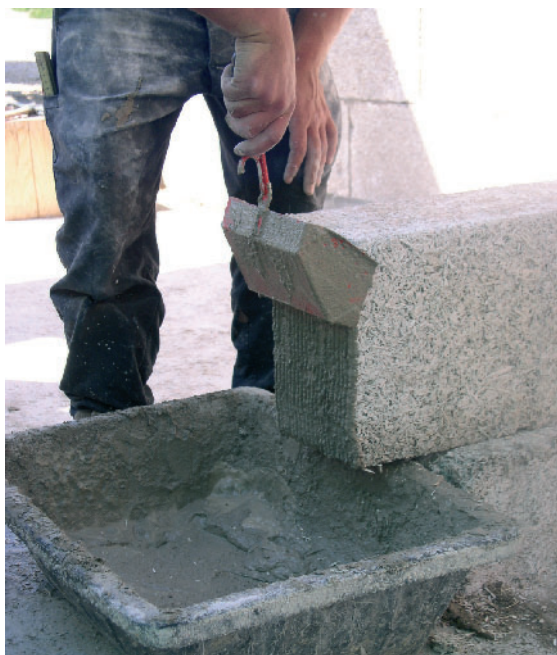
La pose de brique en chanvre
