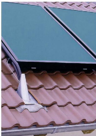
Panneaux solaires toiture « posés »
