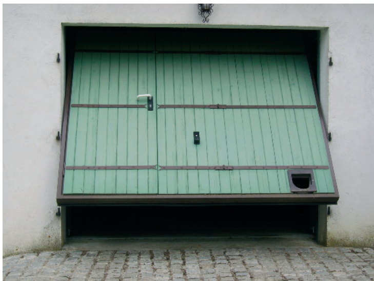
Porte de garage basculante (en bois 22 mm et isolation avec portillon intégré)
